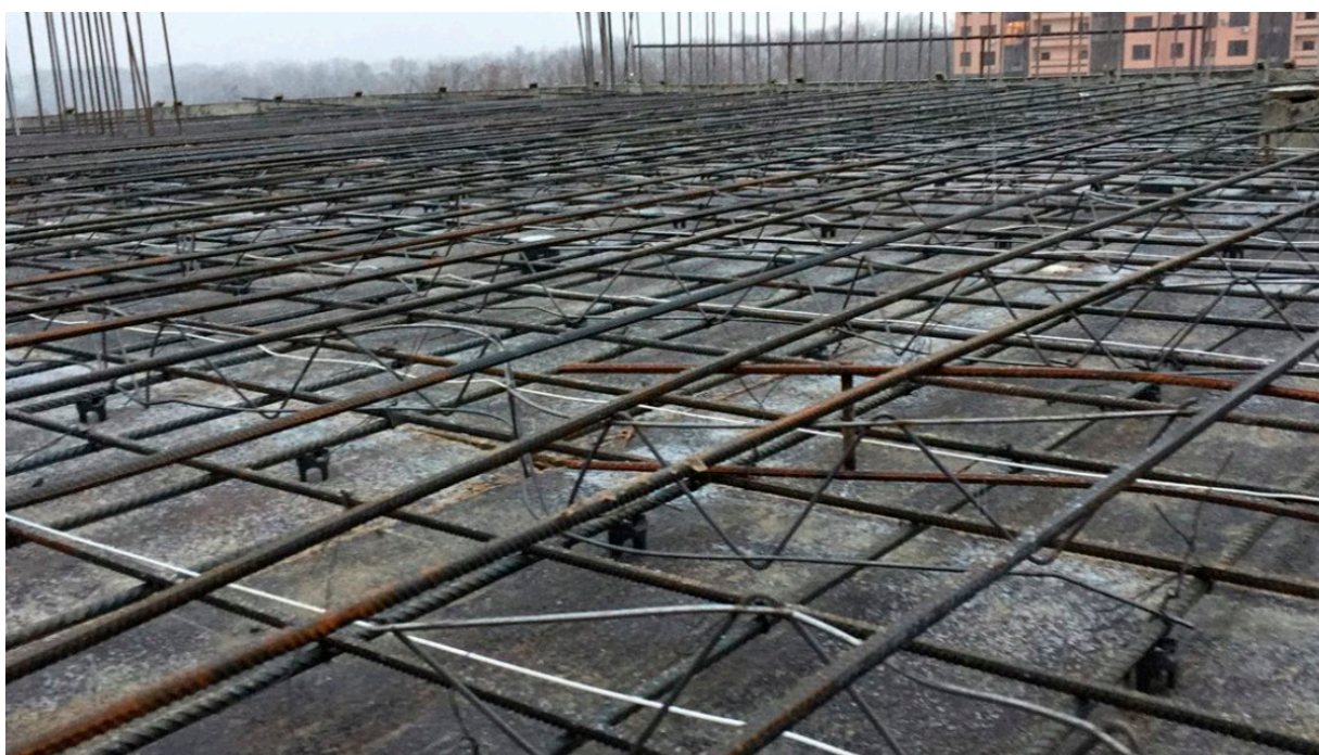
Рис. 6. Армирование фундамента
