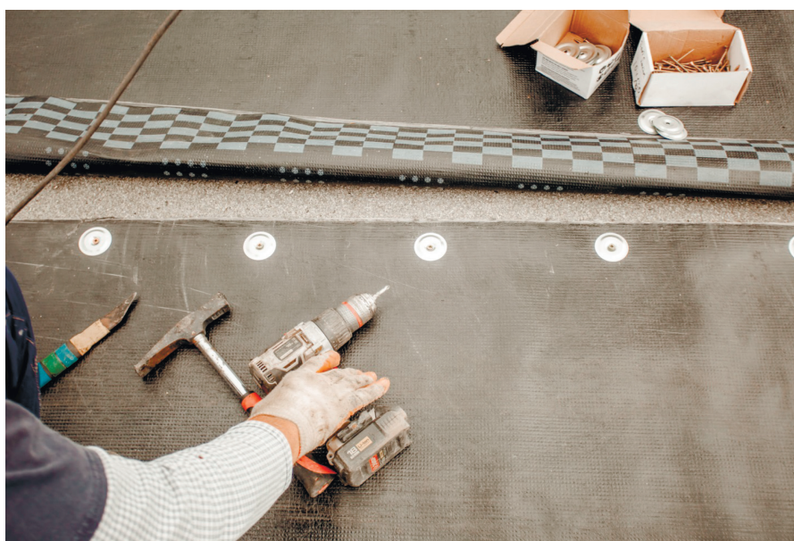
Рис. 3. Установка механического крепежа на нижний слой кровельного ковра
