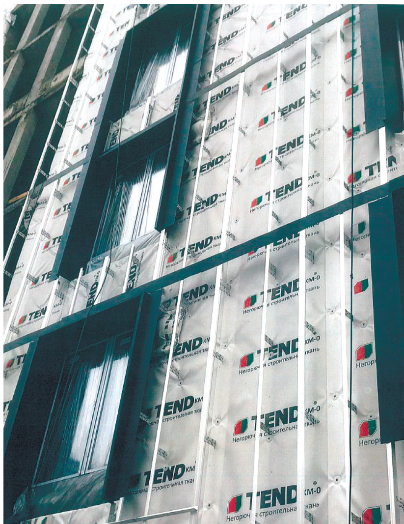
Рис. 3. Фасад здания ЖК «Черная речка», ул. Белоостровская
