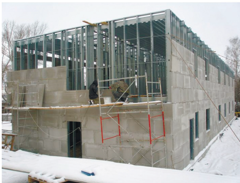
Рис. 7. Монтаж стеновых панелей
