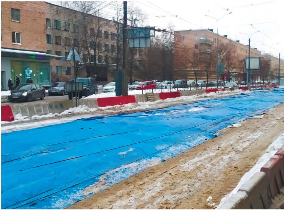
Рис. 4. Производство работ по устройству бесшпальной конструкции в зимний период при выполнении защиты от замерзания
