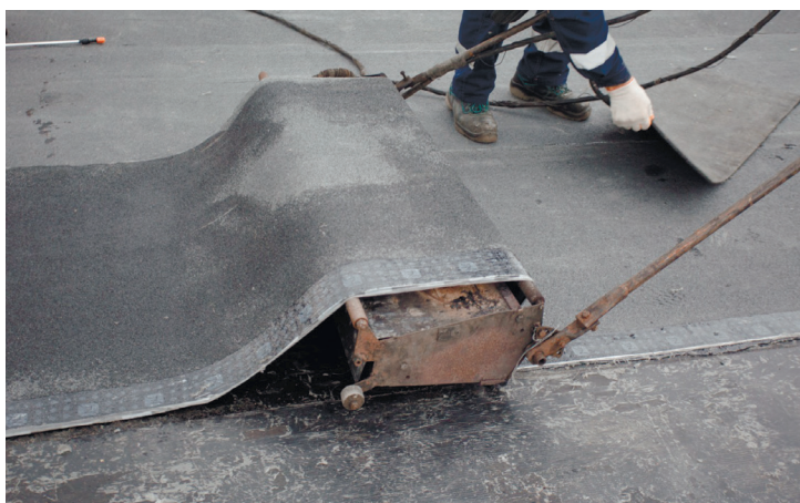
Рис. 5. Наплавление рулонного битумсодержащего материала электрической кровельной машиной
