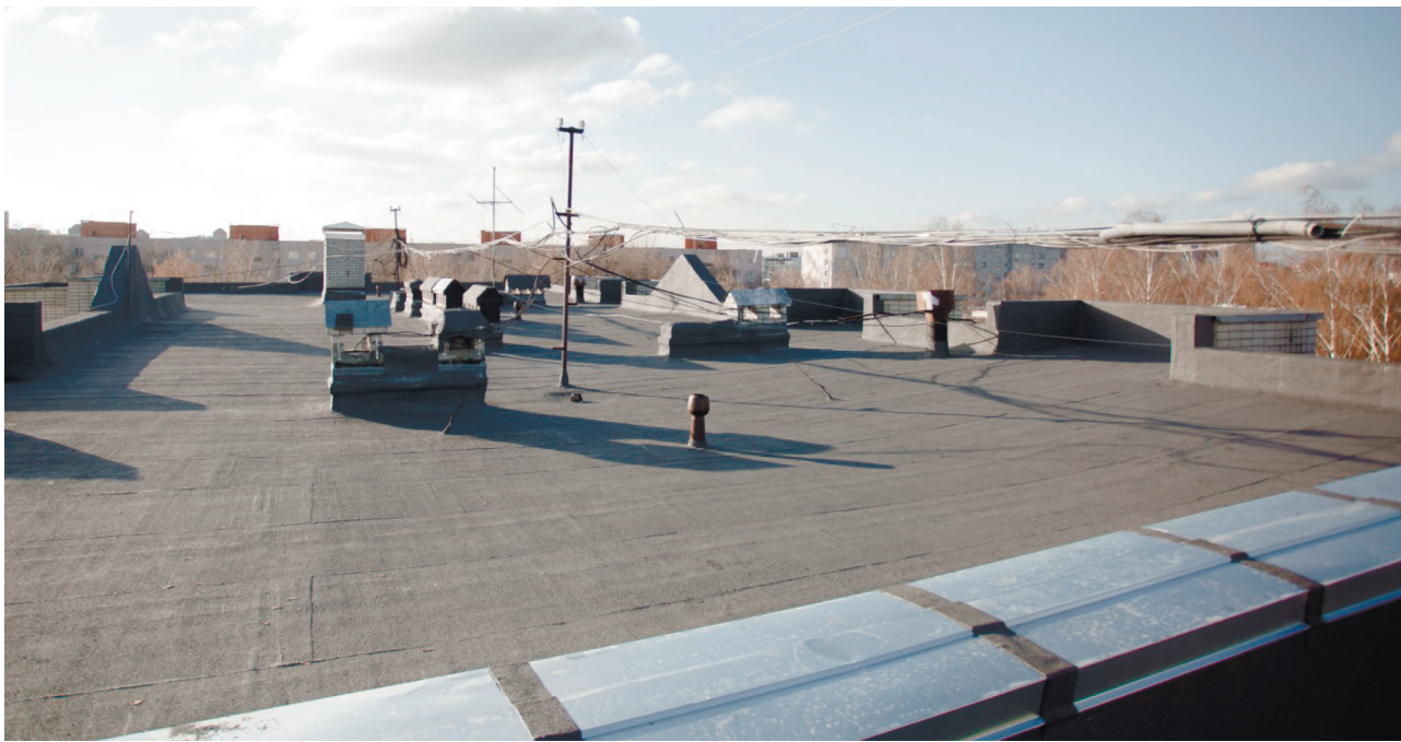
Рис. 8. Общий вид отремонтированной кровли. На переднем плане установлены фартуки на деформационный шов. По центру фотографии виден кровельный вентиляционный патрубок с дефлектором. Парапеты оклеены кровельными материалами полностью
