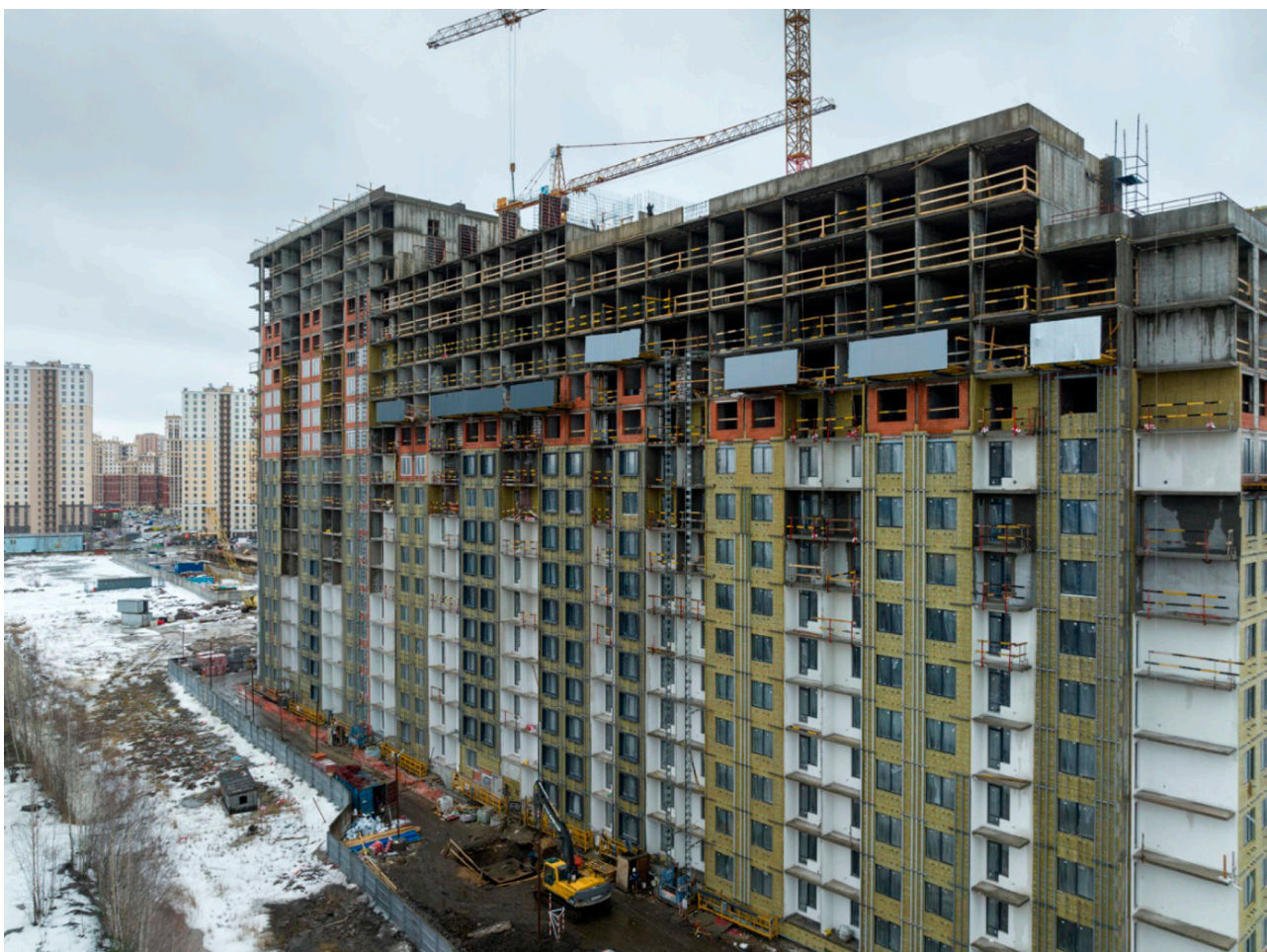
Рис. 2. Последовательность возведения монолитного высотного жилого дома
