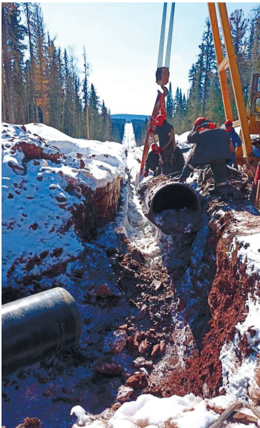
Рис. 1. Прокладка трубопровода в зоне мерзлых и сезонно мёрзлых грунтов
