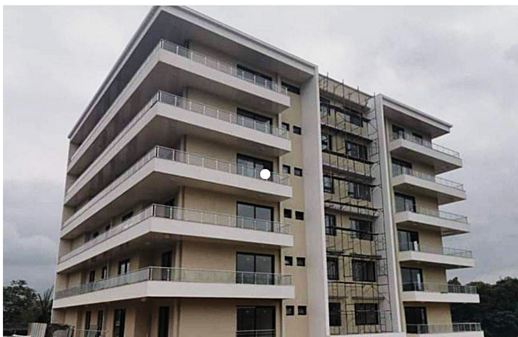
Рис. 3. Строящийся многоквартирный дом, расположенный в районе Кокоди
