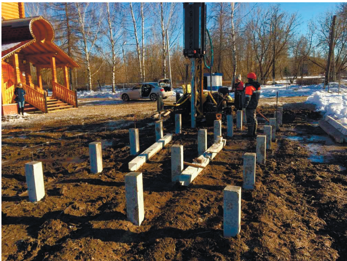
Рис. 5. Забивание железобетонных свай
