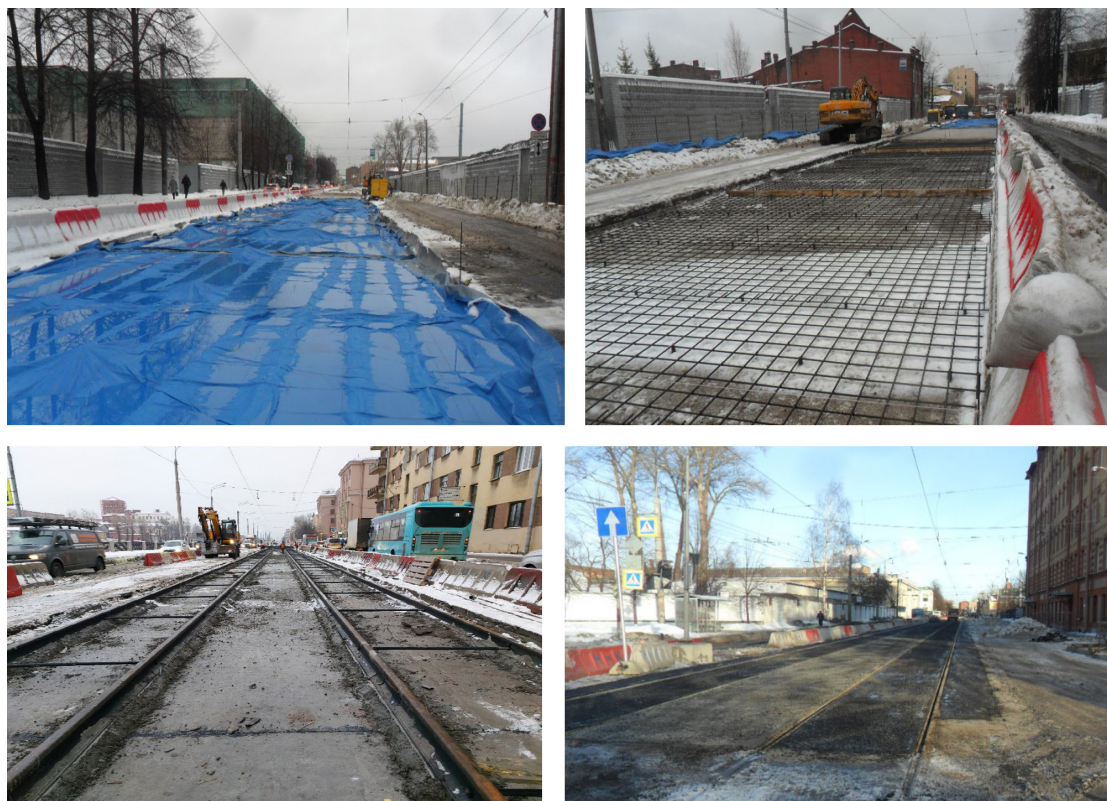
Рис. 6. Производство работ по устройству бесшпальной конструкции в зимний период
