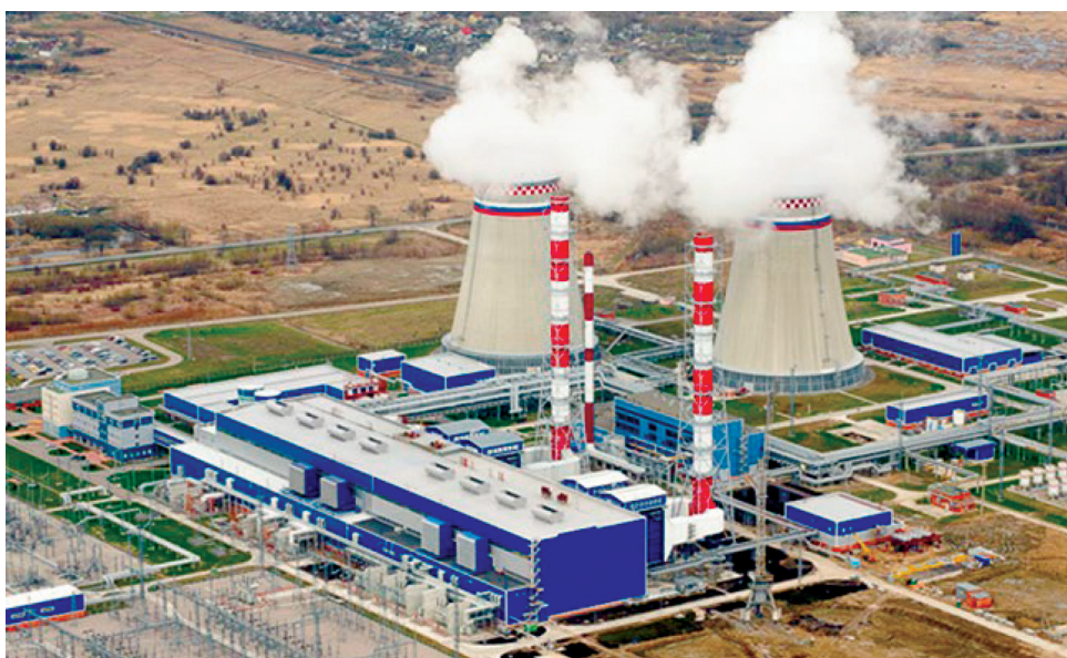
Рис. 1. Тепловая электростанция (ТЭС)
