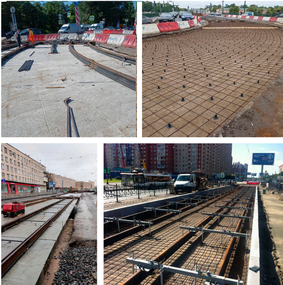
Рис. 5. Производство работ по устройству бесшпальной конструкции в летний период
